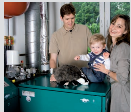
Ein kleines Energiewunder: das BHKW produziert gleichzeitig Wärme und Strom.
